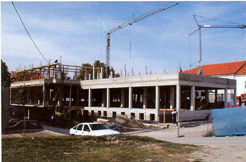
Novi hotel Lav u gradnji
